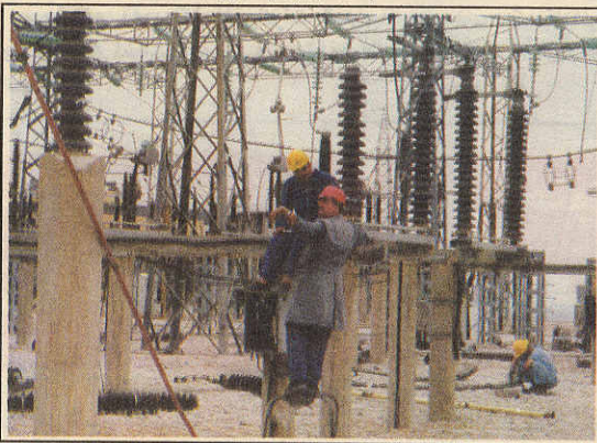
اعمال الترميم في محطة الجمهور
